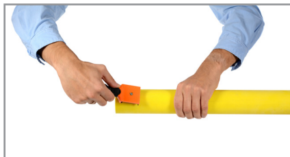
5. Raspar a zona de soldadura do tubo.
