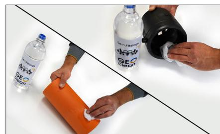
6. Limpar a zona de soldadura com líquido adequado.
