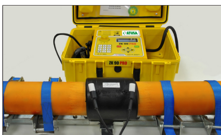
11. Inizio della saldatura. Start welding.
