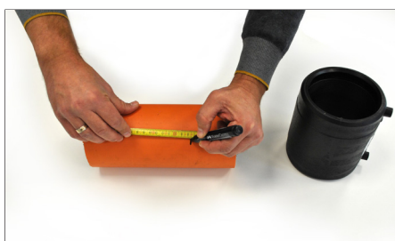
4. Misurare l'area da raschiare. Measure the scraping zone.
