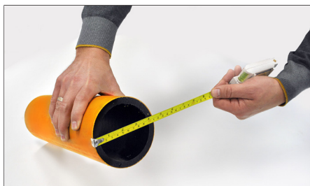
1. Misurare il diametro del tubo. Measure diameter of the pipe.
