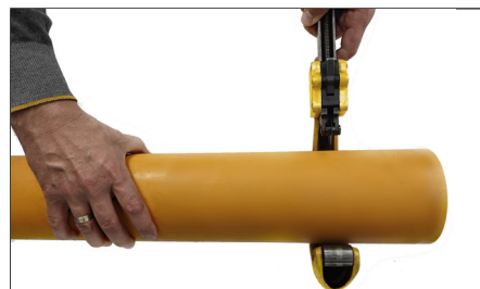
3. Tagliare il tubo in modo perfettamente dritto. Cut the pipe straight.
