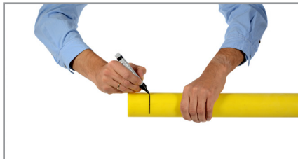
7. Marquer la profondeur d'insertion du tube.
