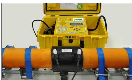
11. Début du soudage. Start welding.
