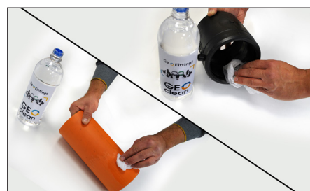
6. Nettoyer la zone de soudage avec un liquide approprié. Clean the welding zone with special liquid.
