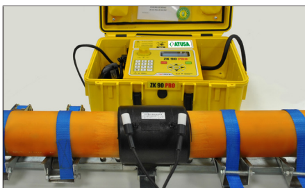
11. Début du soudage. Start welding.
