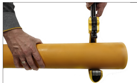
3. Couper le tube totalement droit. Cut the pipe straight.
