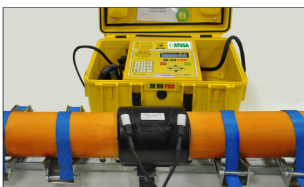
11. Inicio de la soldadura. Start welding.
